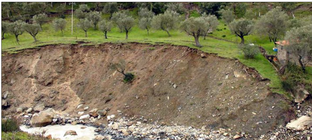
Alcara Li Fusi - Uliveto in prossimità di una frana causata dal Torrente Rosmarino
