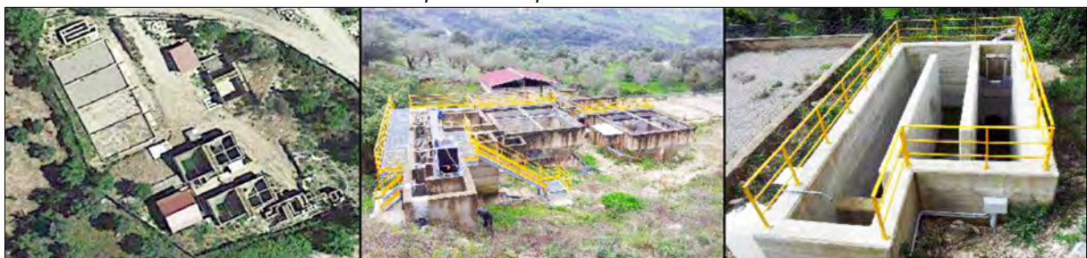
Alcara Li Fusi - Impianto di depurazione sito in località Baratta
