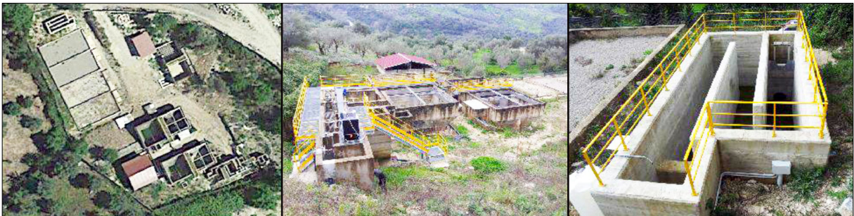
Alcara Li Fusi - Impianto di depurazione sito in località Baratta
